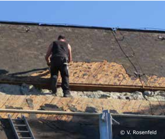
Sanierung des Kirchendachs und Bau einer Photovoltaik-Anlage
