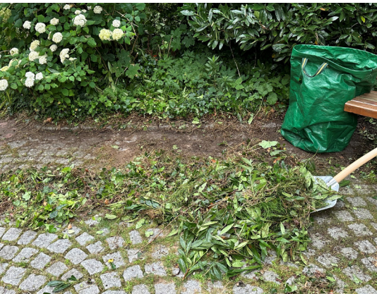
Randsteine waren überwachsen und wurden freigeschnitten
